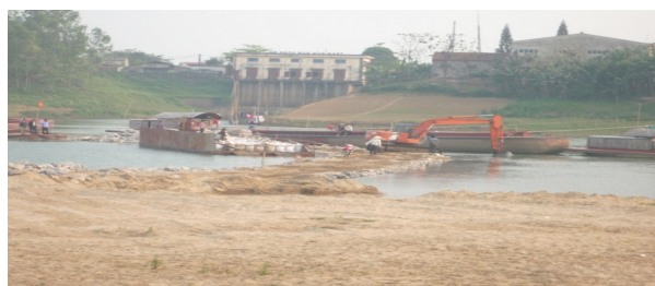
Hình 2. Đập tạm trên sông Mã, sau TB Kiểu
