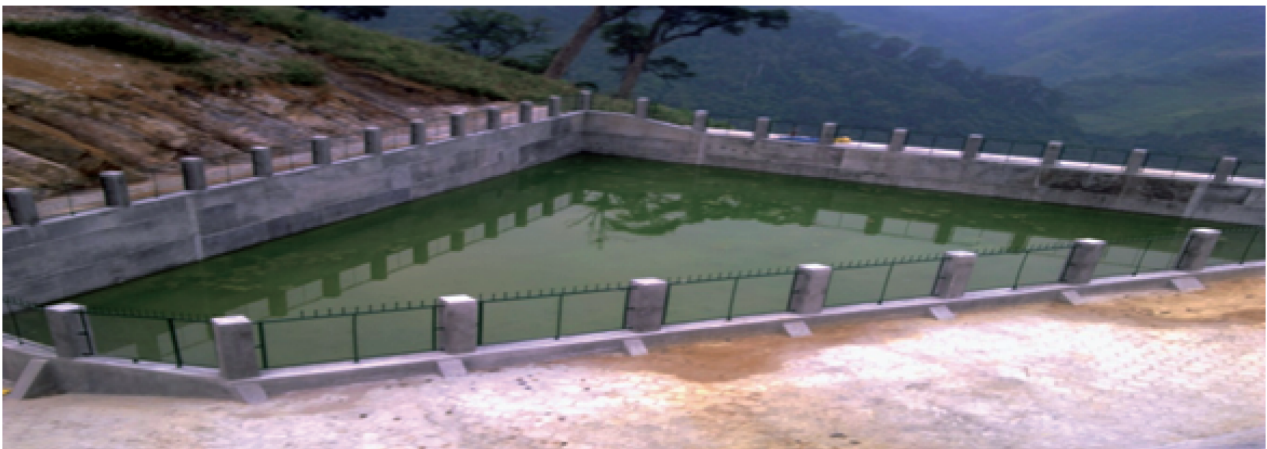
Hồ chứa nước sinh hoạt Lũng Cáng hoàn thành bàn giao đưa vào sử dụng năm 2008
