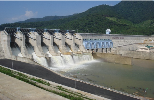
Hình 6. Công trình hồ chứa nước Định Bình
