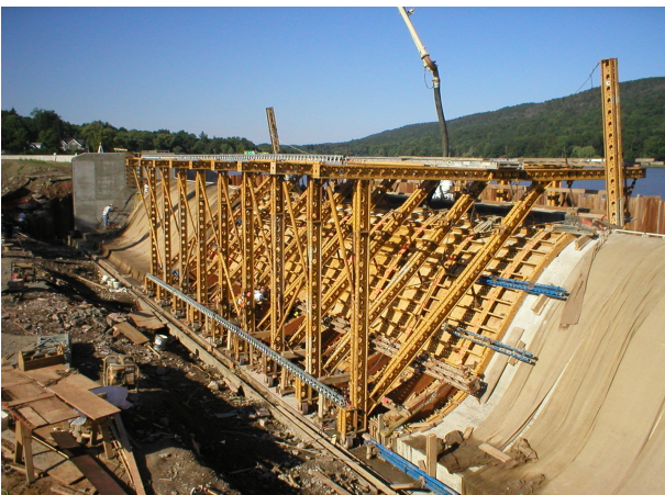
Hình 1. Cốp pha thép đập bê tông sử dụng kết cấu lỗ
